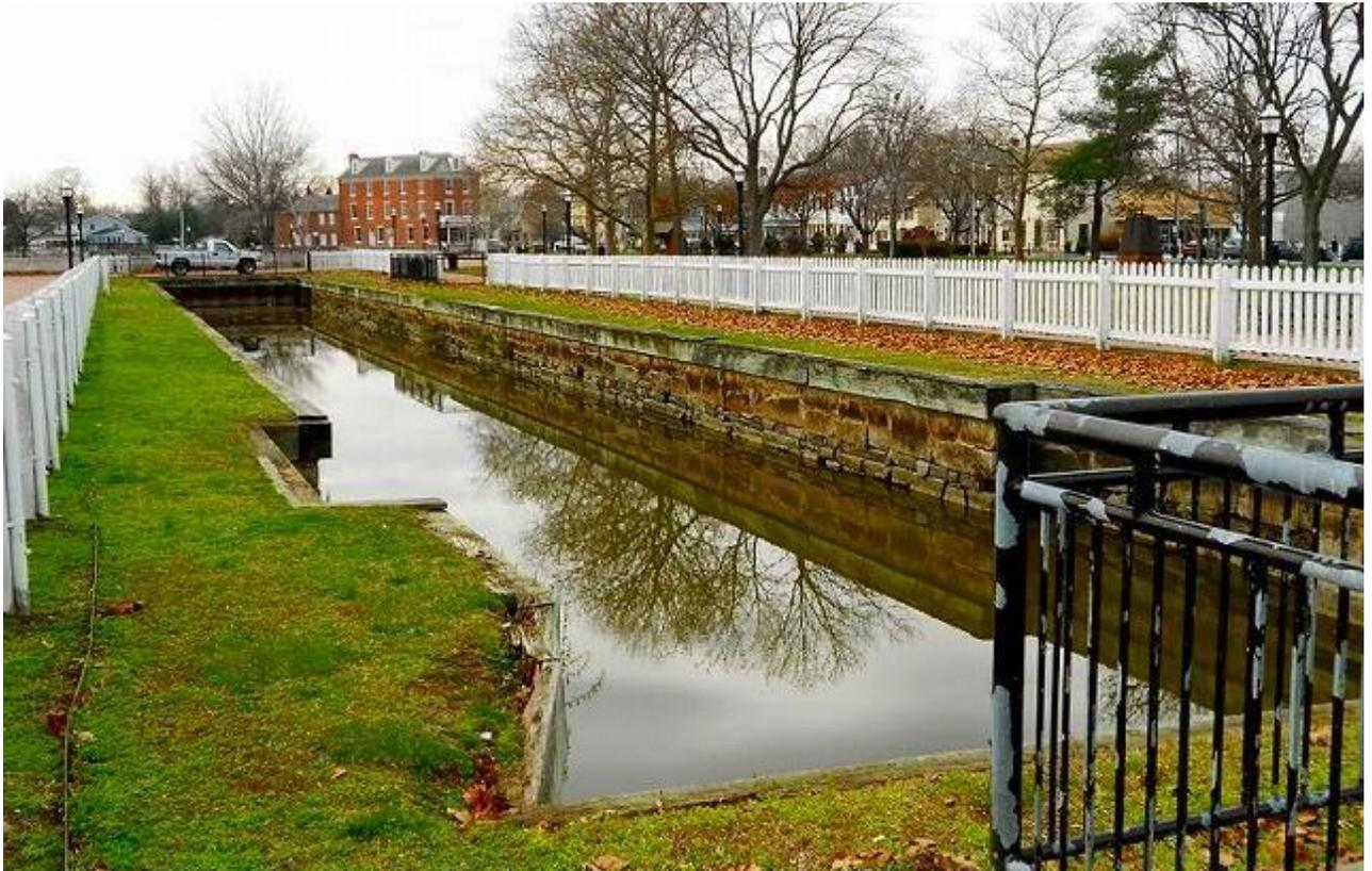
開通当時のロックの巾は 22ft (6.7m)、その後 24ft (7.3m) に拡幅されたいらしい。英国のワイド・ビーム(wide beam 又は broad beam)と呼ばれる内陸運河よりちょっと幅広の物であったようです。どちらも船を馬で曳いた、という点では同じです。その後何度も改良・拡幅が繰り返され、全てのロックを廃して両湾の水面と同一のレベルで結ぶ幅広で機能的な海水面運河 Sea Level Canal に変身したのです。「十九とよた」で通過した頃には全長約 14 哩 (22.5km)、幅は 450ft (137.16m)、深さは 35ft (10.67m)、全部で 6 本ある橋下の最小クリアランスは 136ft (41.5m)、従って吃水さえ調整すればパナマックスでも OK。この地域の各都市を結ぶ輸送手段として極めて重要な役割を果たしていました。
