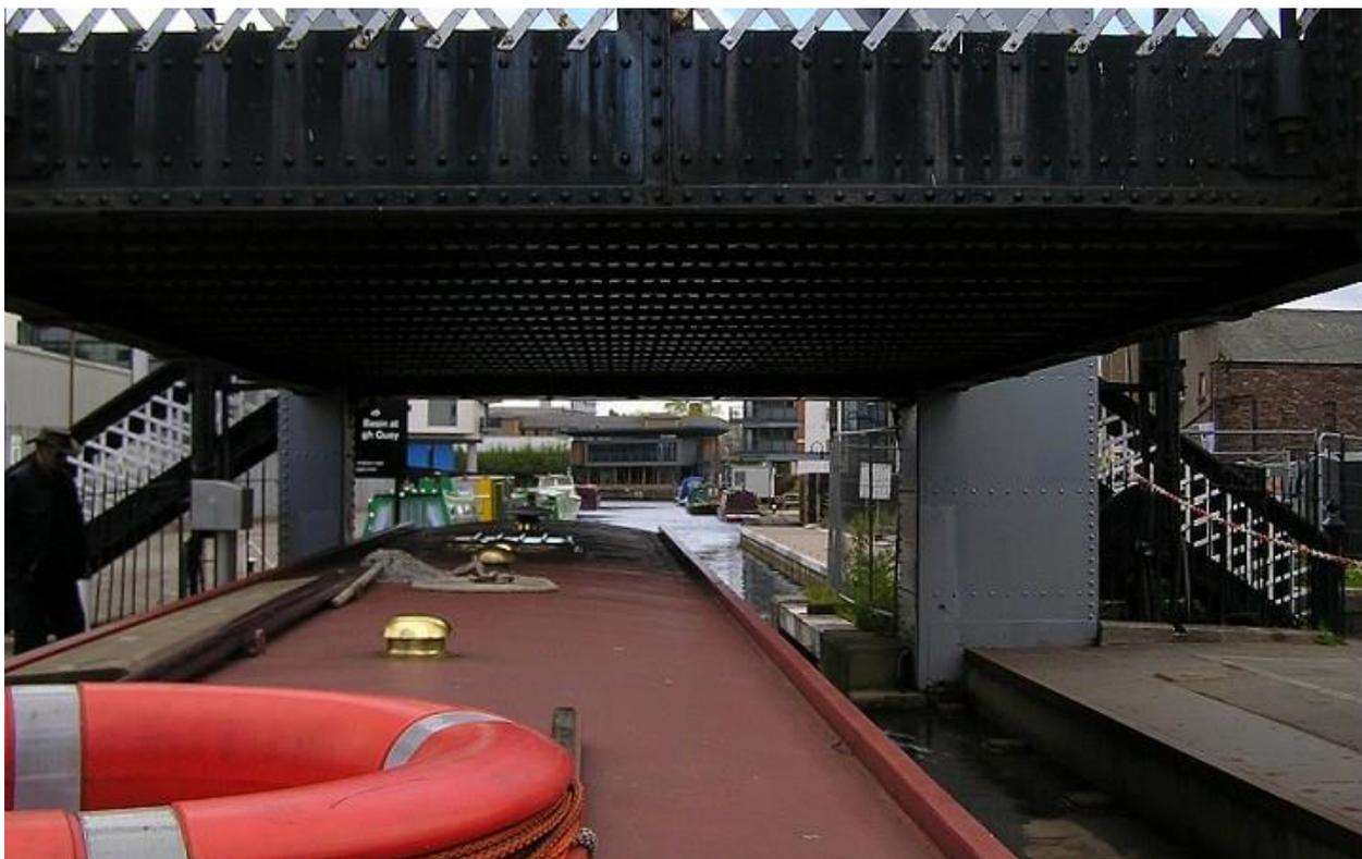
黒い鋼鉄製の部分を持ち上げて船を通すのです。橋を下ろすと、右下の茶色の部分と橋の黒い部分の上面とがツライチになって人や車が通れるようになります。橋が下りた状
