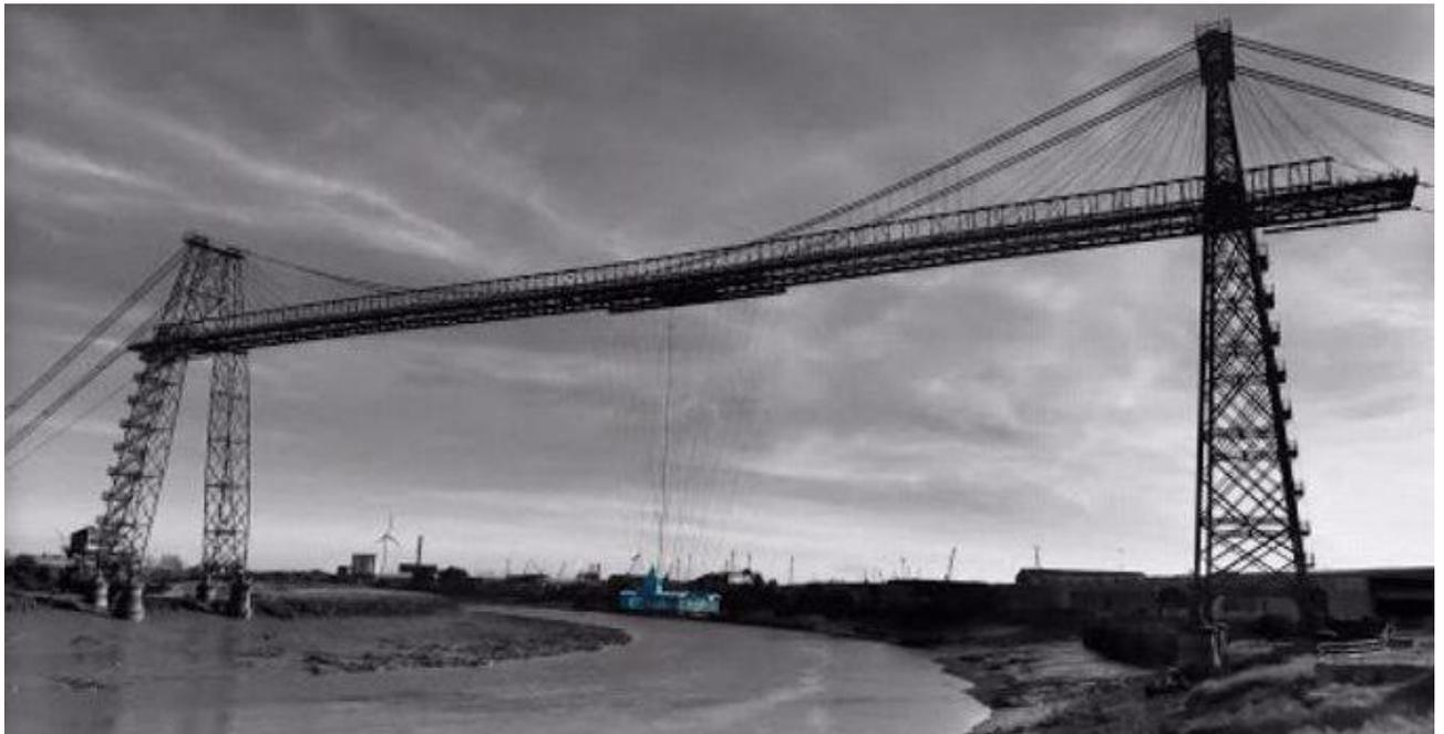
橋の上に行き着くには地面から橋桁の高さまで斜路又はエレベーターが必要ですがそのどちらもありません。元々、船の航行を妨げないようにと考えられたのだそうで、この橋の橋桁はその上を通過するためのものではないんです。橋桁はその下を通航する船の為にできるだけ高くしたい、しかし两岸の土地が低いと橋桁を高くすればするほど低い地面から橋桁に行きつくことが難しくなります。そこで考えられたのがこの方式。
