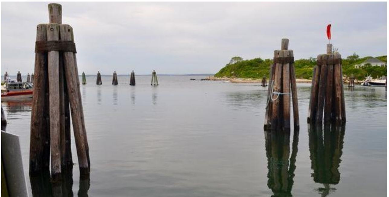
ドルフィンの一つ一つは、こんな風に丸太の杭を何本か海底又は河底に打ち込んで、頭部をワイヤーで束ねてあります。これを上図左半分の遠景に見えるように、船の全長以上（200メートル余り）の長さに並べて設置し、そこに船を係留します。
