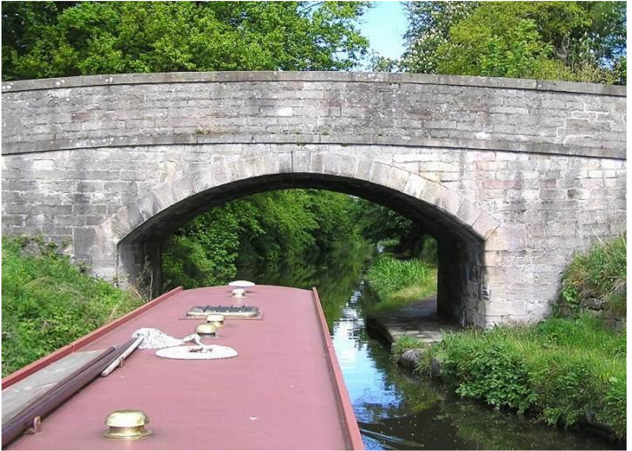
橋番号14番、Gogar Moor Bridge ゴガー・ムーア・ブリッジ。これはラソーにあるブリッジのひとつ、エディンバラ寄りのもので、形は全く同じです。
