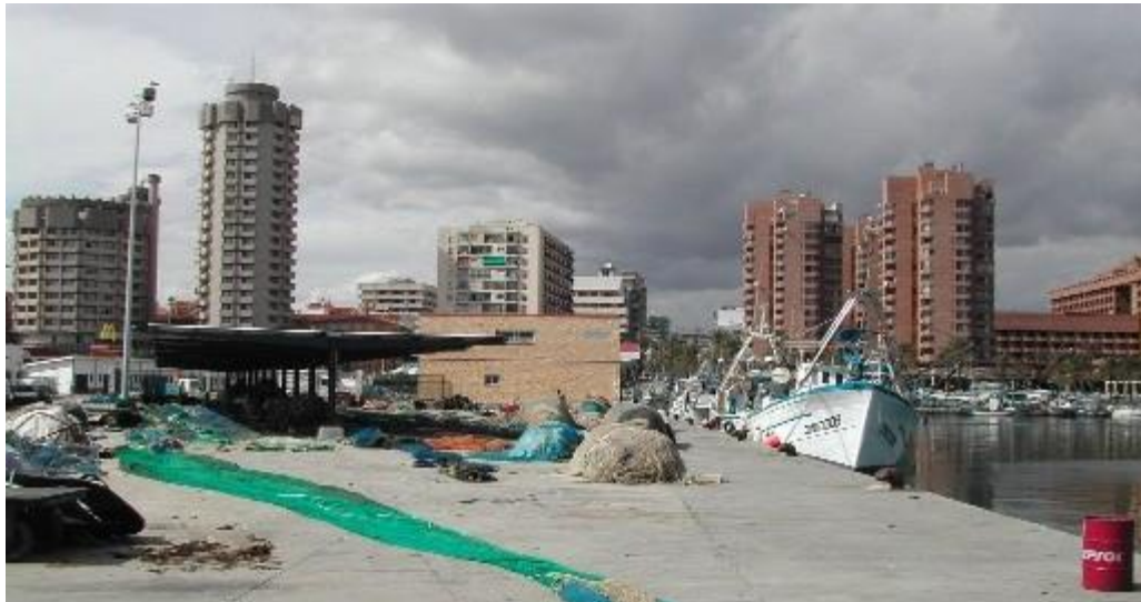
(港の西側、漁船溜まりと海岸遊歩道に面したホテル群)
