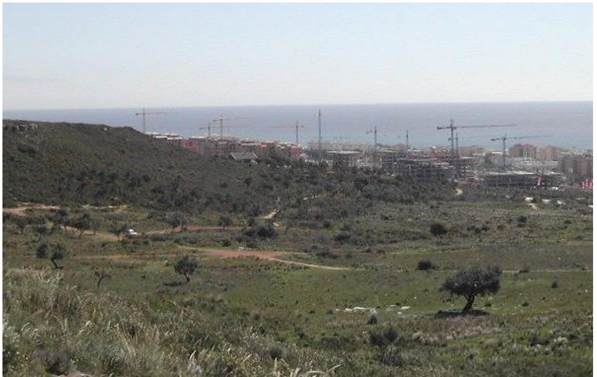
(マンション建設ラッシュでクレーン林立)
